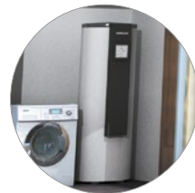
2. Ballon d'eau chaude
